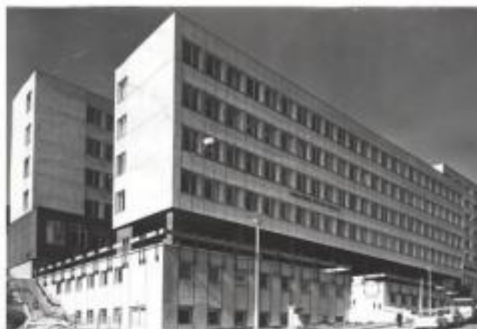
a Doberdó úti homlokzat
