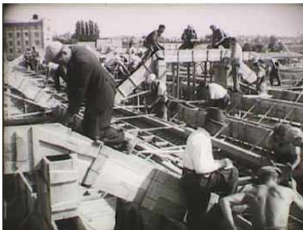
A Szegedi Textilművek üzemcsarnokának építése
