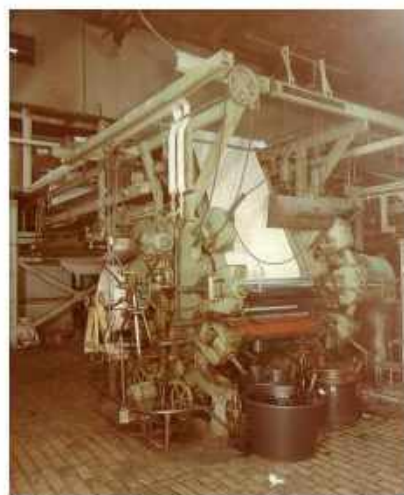
Nyolcszínű hengernyomógép a Textilfestőgyárban az 1960-as években
