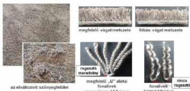
Padiószőnyeg flórréteg hullása baloldali rögzítési hiba miatt
