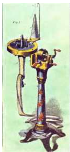
6. ábra. Kezdetleges körkötő- gép harisnyacső ké- szítésére (1859)
