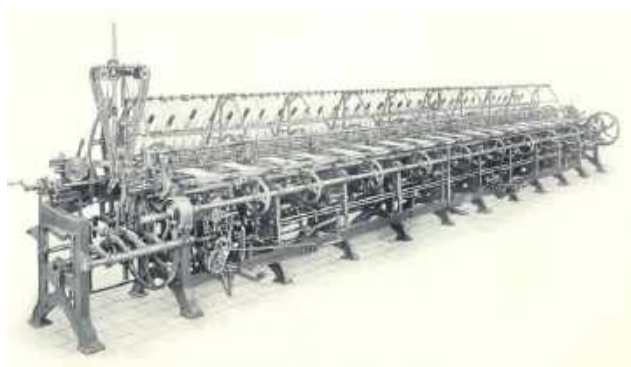
9. ábra. Síkhurkológép (20. sz. eleje)
