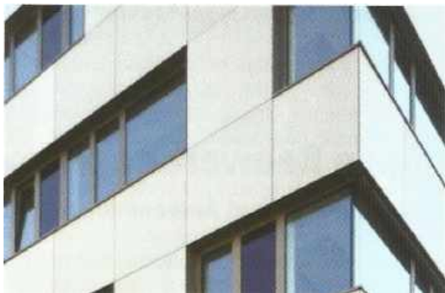
4. ábra. Textilbeton homlokzati elemek
