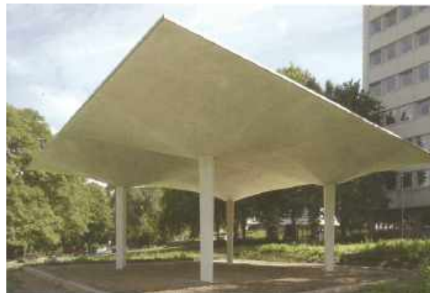
5. ábra. Textilbeton tető
