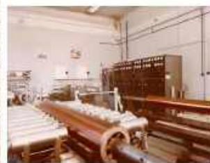
Nyomóhenger-készítés elektromos pantográfval
